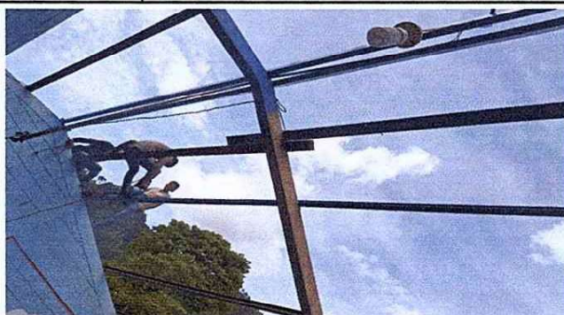
Foto 2: Mantenimiento de estructura de metal para mayor vida útil (lijado y pintado)
