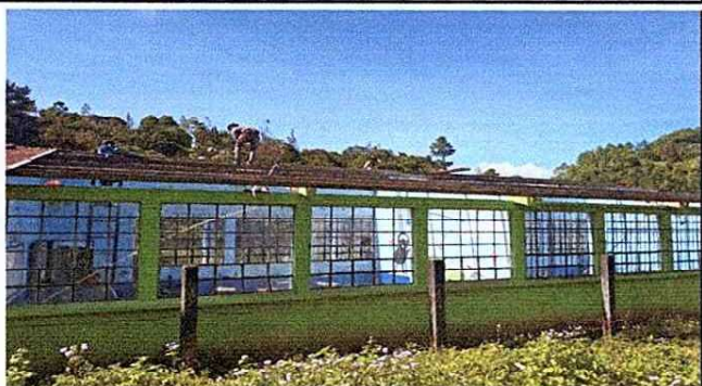
Foto 1: Desinstalación lámina acanalada en mal estado por lámina troquelada.
