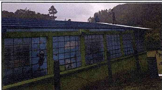
Foto 7: Instalación de lamina troquelada para mejorar el ambiente educativo (AULAS).
